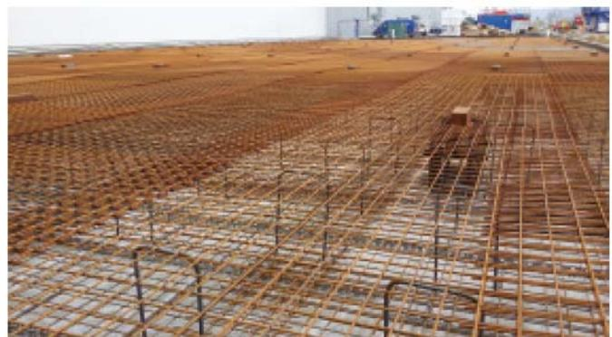
Bild 6. Fugenfreie Fundamentplatte: Grundbew.: 5,03cm<sup>2</sup>/m ob. und unt.
