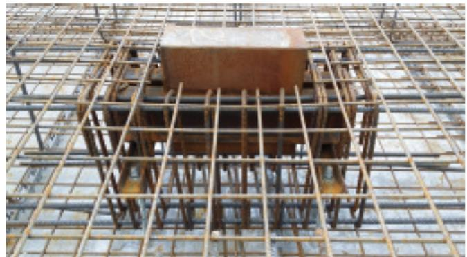
Bild 5. Detail: Ankerkasten in der Fundamentplatte
