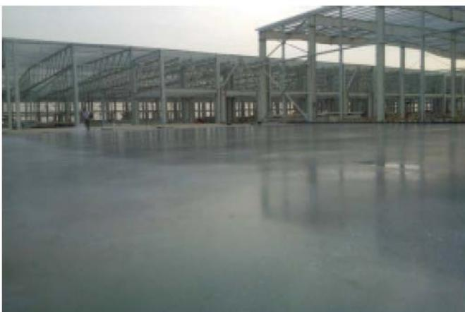
Bild 3. Fertige Oberfläche der Fundamentplatte eines Plattenfelds
