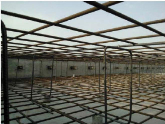
Bild 2. Entspannte Bewehrungsführung der Fundamentplatte
